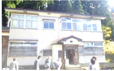
↑ 廃校になった地元小学校校舎を利用したNPO法人の事務所兼研修センター
