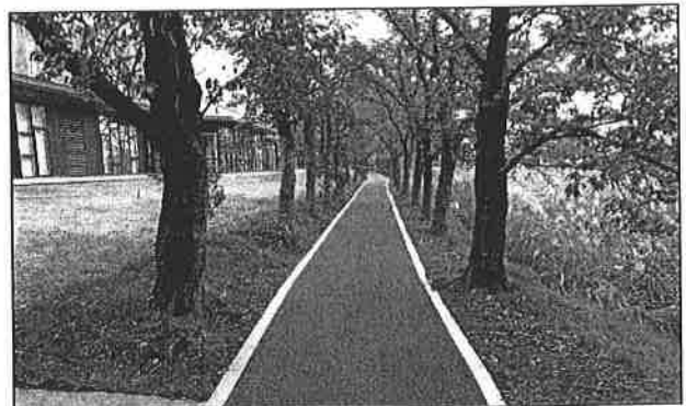
園路改築工事
