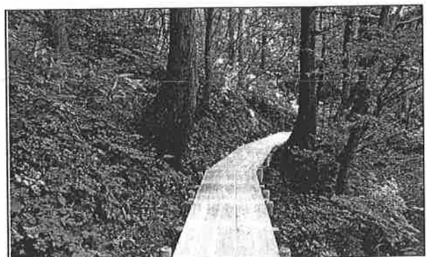
散策路整備工事
