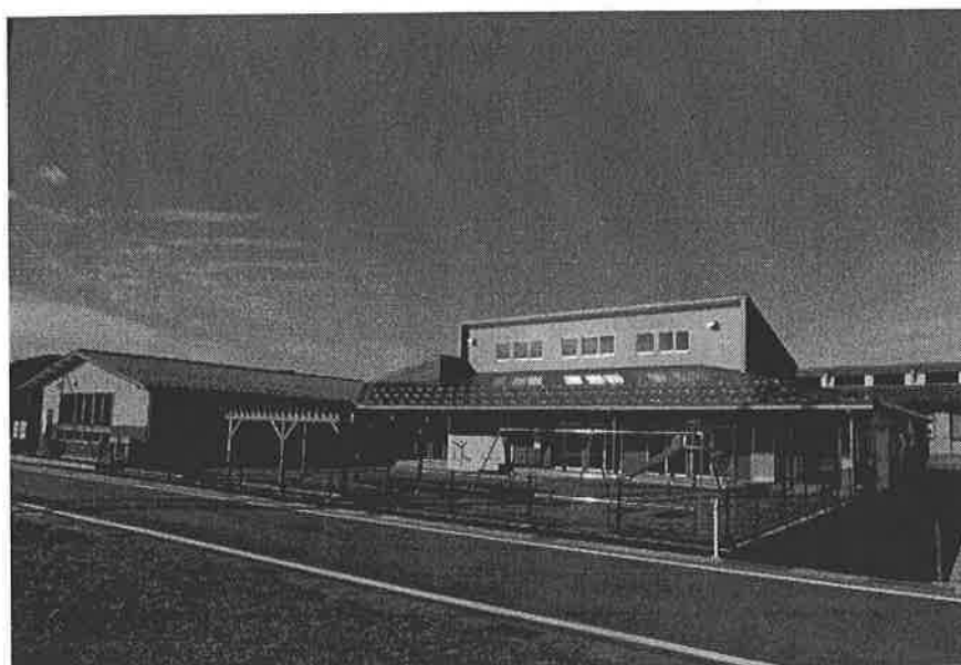
名立区新保育園 完成写真
