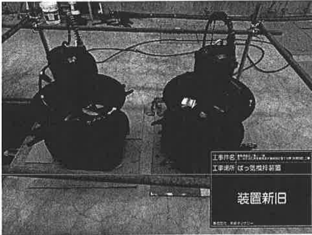
ばっ気攪拌装置更新 (処理施設 機械設備工事)
