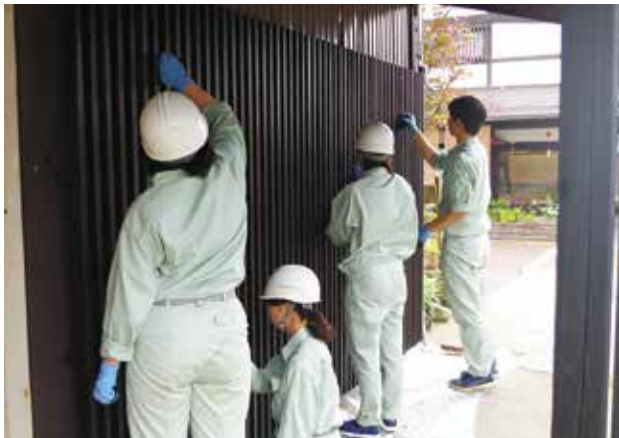
上越総合技術高等学校の生徒と住民が連携し、雁木の塗装などを行う修景活動を行っています。
