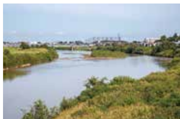
現在、撤去工事が着手された
