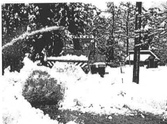
道路排雪状況 (浦川原区中猪子田地内)
