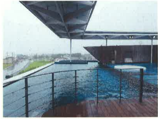
図3. 海側に風除け壁がなく、 屋根には大きな開口
