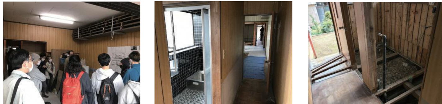
見学会の様子 工事の様子（浴室はそのまま） 工事の様子（トイレは改修）
