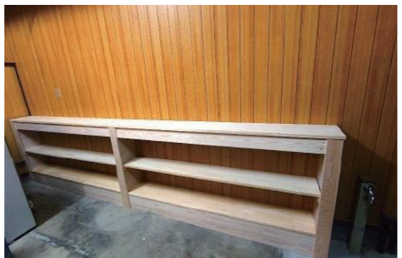
改修後（土間に給水管カバー兼用の棚を設置）
