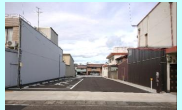
高田小町駐車場
