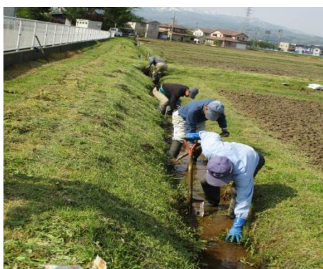
水路の泥上げ
