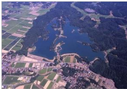
※下流域の集落状況
