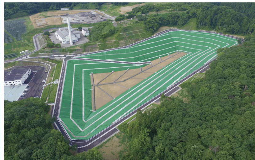
第3期処分場（全景）
