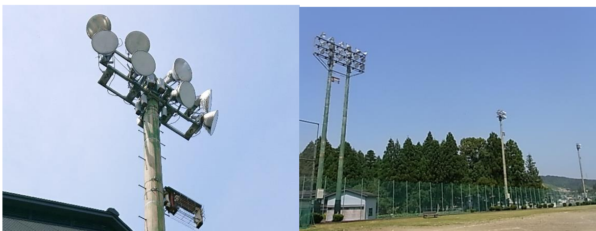
現在の状況写真（令和3年6月11日撮影）
