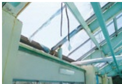
柿崎プールのガラス屋根破損状況
