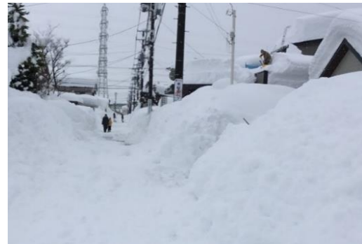
【市道市役所前通線 (木田一丁目地内)】 〔 路肩への堆雪により車両が通行できず排雪作業が必要な状況 〕
