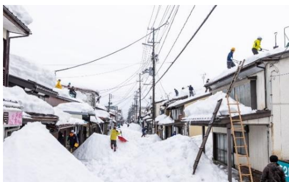
【屋根雪下ろし作業状況】 （南本町三丁目地内）
