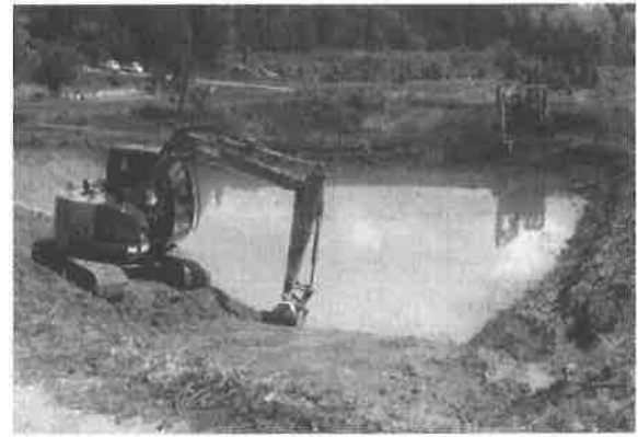
ため池の修繕（安塚区坊金地内）
