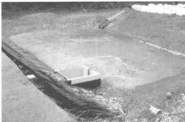
貯留施設の新設（頸城区玄僧地内）
