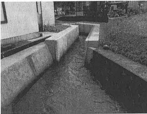
〔雨水排水路改修工事（東城町三丁目地内）〕
