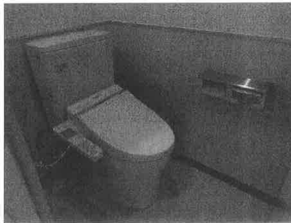
便器の洋式化及び床のドライ化 (板倉中校舎)
