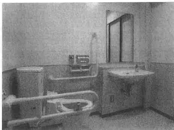
多目的トイレの設置 (板倉中校舎)
