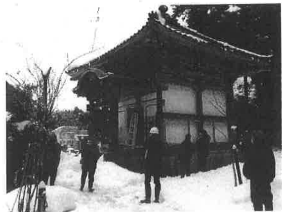
善徳寺経堂(完了確認の様子)
