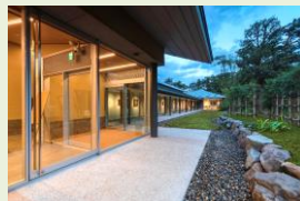
<外構工事完了状況>
