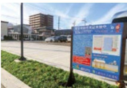
ガス水道局庁舎の堆雪場に設置された地中熱融雪設備
