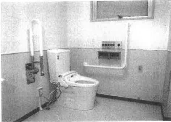
多目的トイレの設置（南川小体育館）
