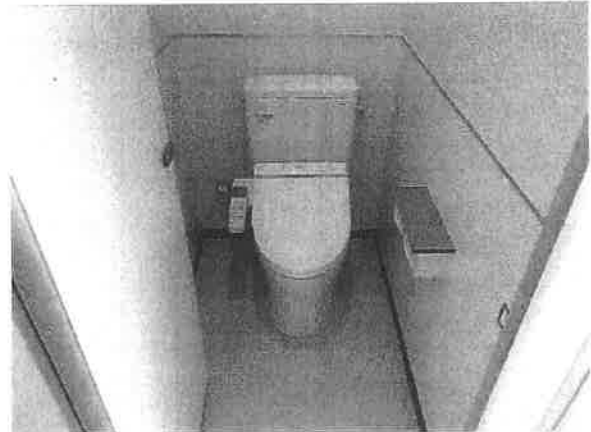
便器の洋式化及び床のドライ化（大瀬小校舎）
