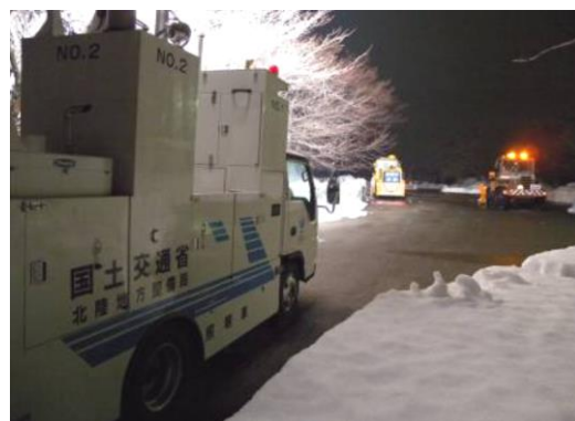
【夜間作業の状況】 （国土交通省 夜間照明車）
