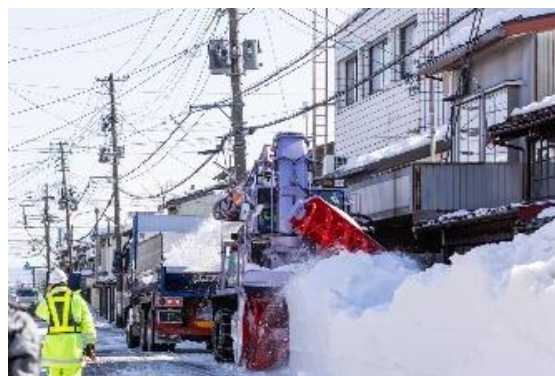
【一車線後方積込型ロータリー 除雪車による作業】 （東本町二丁目地内）
