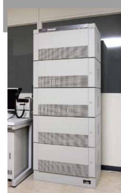
デジタル移動無線システム全体の通信を制御しており、統制台、運用管理装置/自動通信記録装置、交換機接続装置、統制局用遠隔制御装置、コミュニケーションサーバと接続しています。
