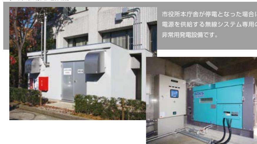
市役所本庁舎が停電となった場合に電源を供給する無線システム専用の非常用発電設備です。
