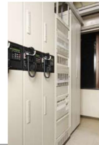
7.5GHz帯の多重無線設備で市役所本庁と各中継局の基地局間を結ぶ無線回線を構築しています。
