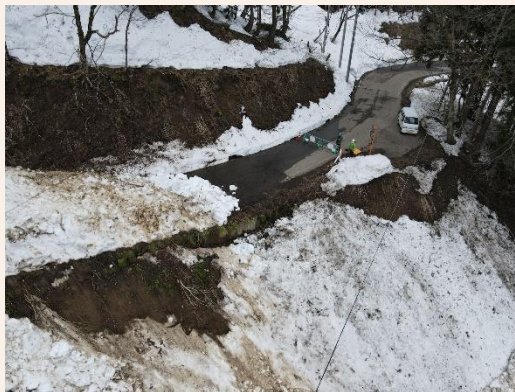
ドローンでの地すべり現場の空撮
