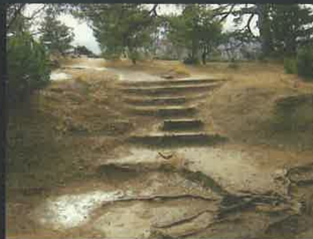
雨水等による流土(天守台跡)
