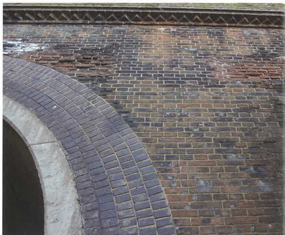
北陸線谷浜トンネル 今は久比岐自転車道のトンネル
