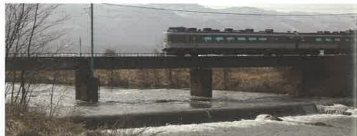
信越線矢代川鉄橋橋 脚の一部が建築当時の石積みのみらしい
