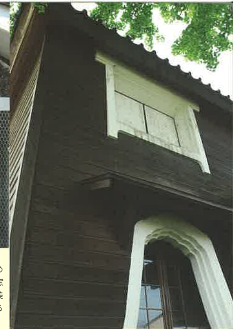
横なぐりの風雨を避けるため下見板が張られているが、窓部などでは白い土蔵造りの美しさが健在。扉を全て閉めると中は真っ暗になるという。
