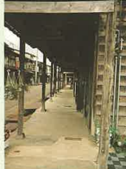
18 雁木(東本町4) 雁木の美しい街並みを保存することに住民が努力を払い、一つの提案ともなっている。地域の景観づくりを考える契機となることを望む。
