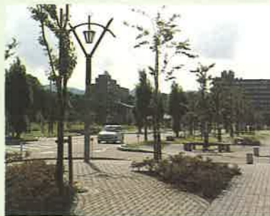
4 上越教育大学前遊歩道 土地区画整理事業により整備された広い歩道。地域が大学を大切に守り、その環境を築いていこうとしている様子がうかがえる。
