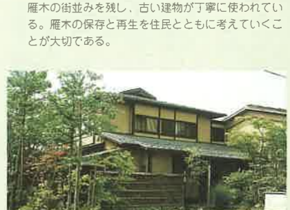
24 高橋孫左衛門商店(南本町3) 雁木の街並みを残し、古い建物が丁寧に使われている。雁木の保存と再生を住民とともに考えていくことが大切である。
