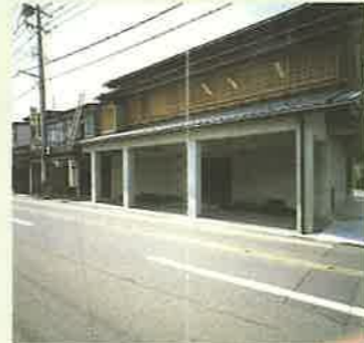
14 株清水組社屋(稲田3) 建築にコンクリートを使用しているが周囲と違和感がなく、自分の生活するまちに対する愛情が感じられる。
