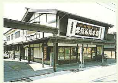
24 高橋孫左衛門商店(南本町3) 雁木の街並みを残し、古い建物が丁寧に使われている。雁木の保存と再生を住民とともに考えていくことが大切である。
