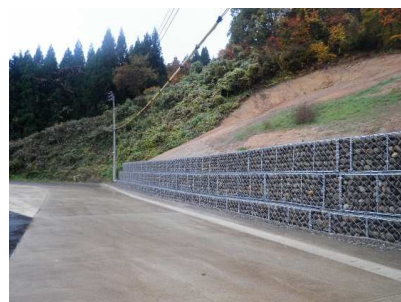
災害防止対策工事の施工例 (清里区青柳地内)
