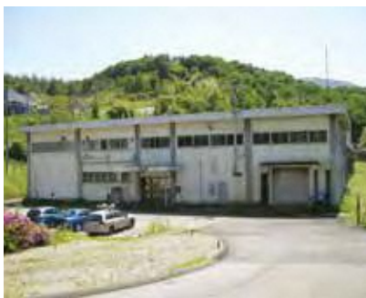
昭和43年に竣工した城山浄水場
