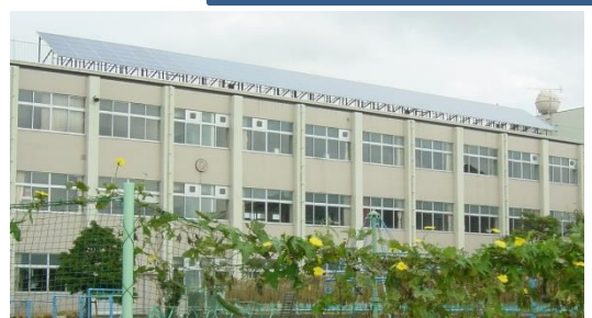
富岡小学校に設置した太陽光パネル
