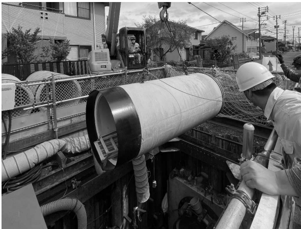
〔雨水管渠工事（御殿山町地内）〕
