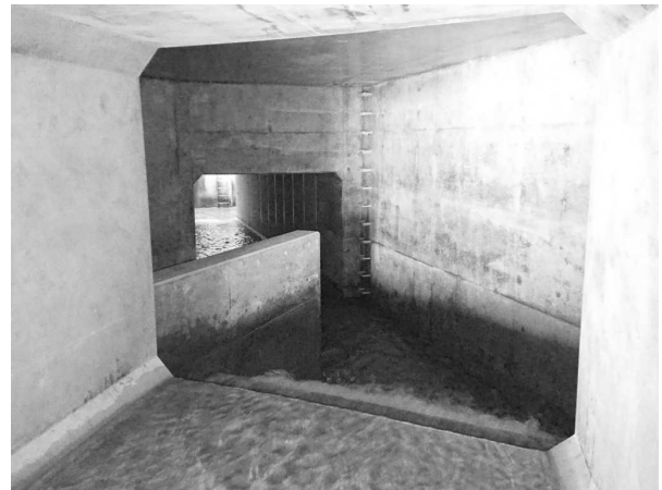
〔雨水管渠工事（北城町一丁目地内）〕
