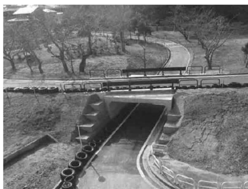
ゴーカートコース橋梁更新工事
