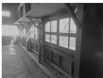
旧今井染物屋 耐震改修工事
