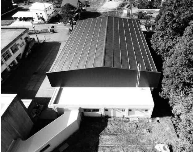
黒田小学校体育館屋根改修状況
