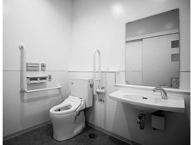
黒田小学校体育館トイレ改修状況
