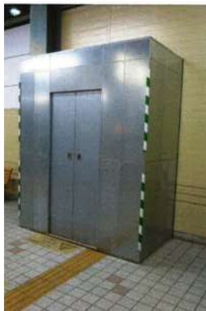
1階、3階のエレベーター前に仮囲いを設置
