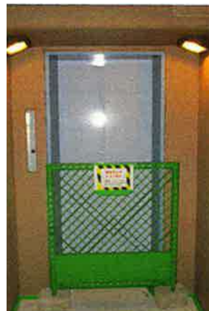
2階のエレベーター前はフェンスを設置
