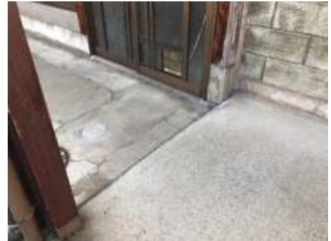
隣接する雁木、道路面との段差
