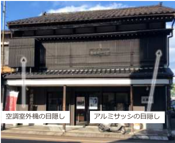
アルミサッシ、空調室外機が目隠し
