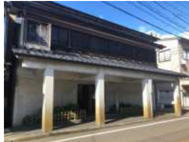
鉄筋コンクリート造
