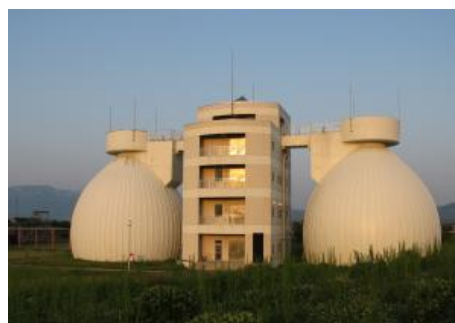
下水道センターの処理施設
