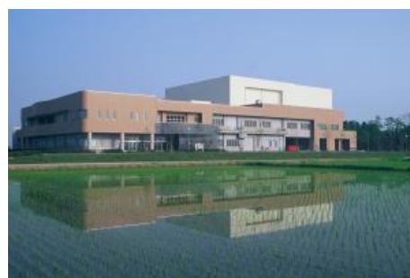
汚泥リサイクルパーク
