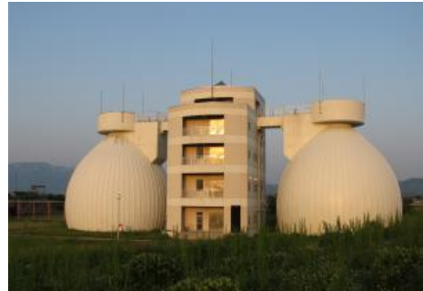
下水道センターの処理施設
