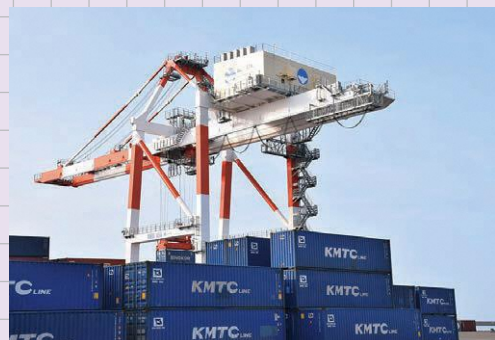
▲直江津港のガントリークレーン
