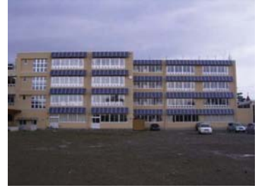
大町小学校に設置した太陽光発電設備
