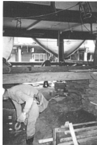
図 1-26 昭和 56 年の工事
