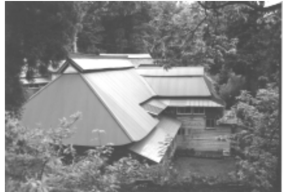
図 4-6 屋根を切り上げて設けられた窓
