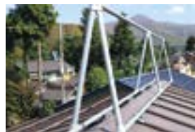
命綱固定アンカーの設置例
