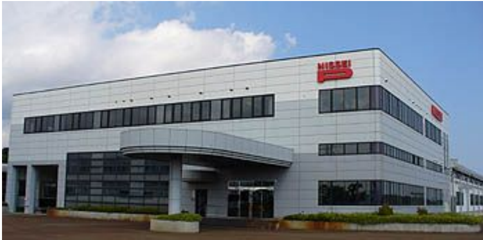
写真 1-2 日精樹脂工業(株) 上越工場
