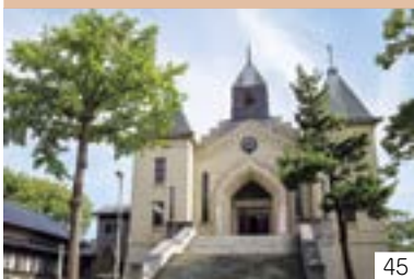
浄善寺本堂と大ケヤキ（柿崎区） 浄善寺門徒講
