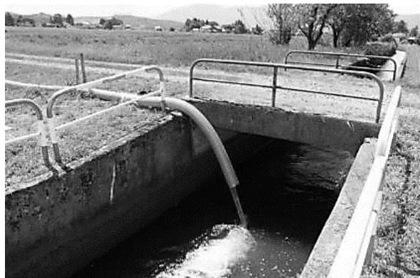
板倉区田屋地内（上江幹線用水路）
