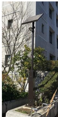
写真 大町小学校(左上) 雪だるま物産館(左下) 上越市役所木田庁舎(右) 注:屋外照明のみ
