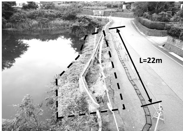
〔 被災状況（令和5年9月） 〕 道路法面の崩落
