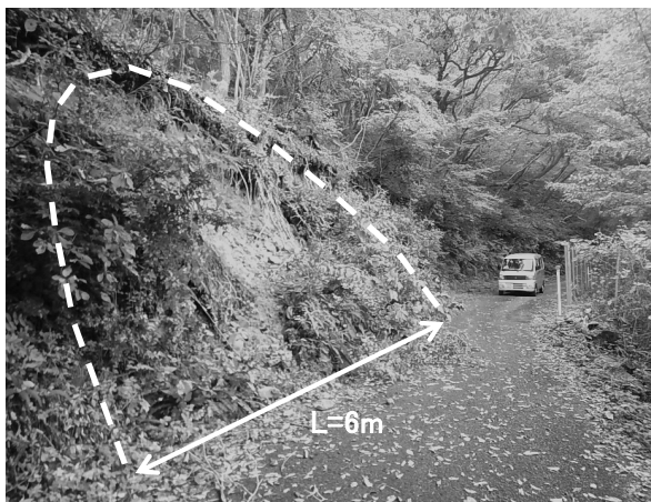
〔頸城区 大蒲生田線〕 道路法面の崩落
