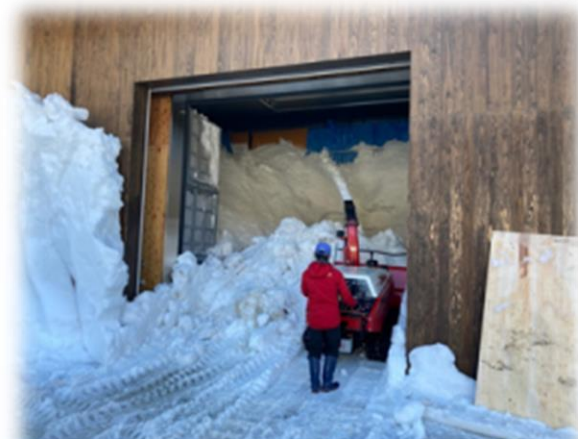
▲雪入れ作業の様子
